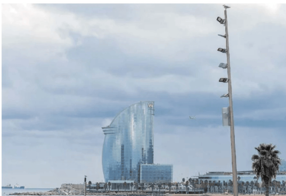
Una antena de telecomunicaciones instalada por Cellnex junto a la playa de Barcelona. D. ZORRAKINO (EP / GETTY IMAGES)
